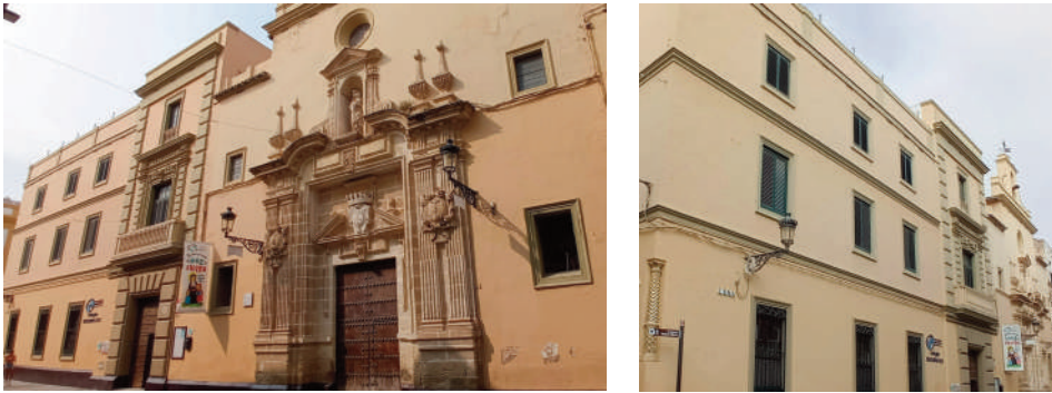
Estado actual de la fachada del convento-colegio de las Esclavas en calle Luna. Foto: autor.
