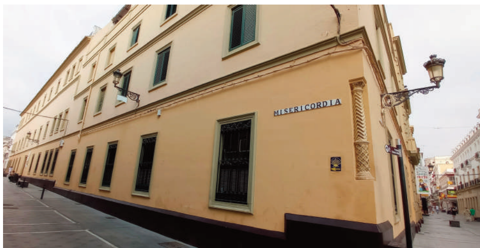
Estado actual de la fachada del convento-colegio de las Esclavas en calle Misericordia. Foto: autor.
