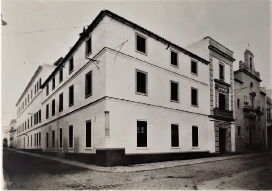
Doble fachada del antiguo hospital de San Juan de Dios convertido en convento y colegio de Esclavas en El Puerto. Foto: Archivo de Patrimonio Histórico de El Puerto.
