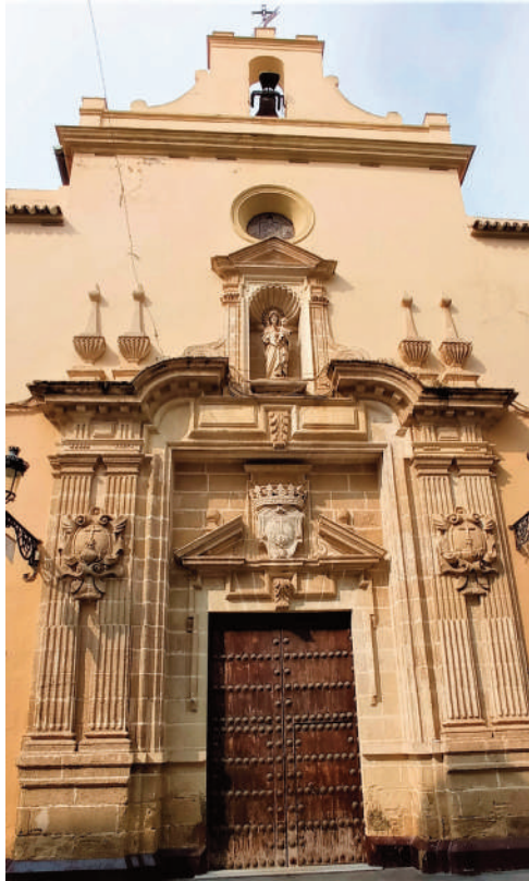
Portada de la antigua capilla hospitalaria de San Juan de Dios. Foto: autor.
