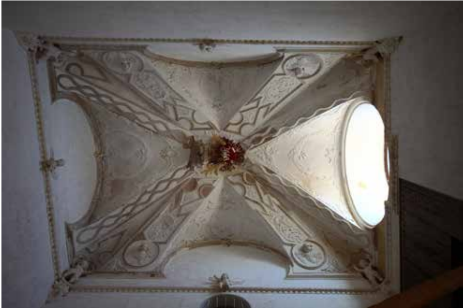
Ilustración 3. Bóveda de la escalera (Fotografía A. Aguayo)
