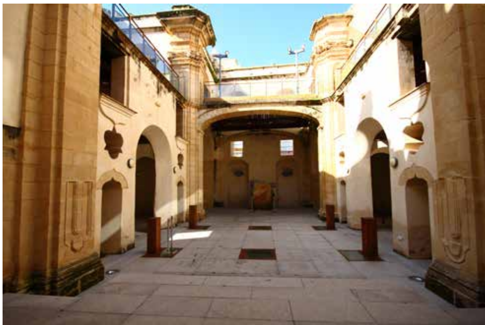
Ilustración 23. Interior de la iglesia (Fotografía A. Aguayo)
