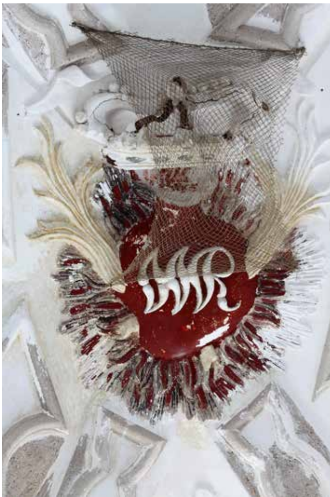
Ilustración 4. Clave de la bóveda (Fotografía A. Aguayo)
