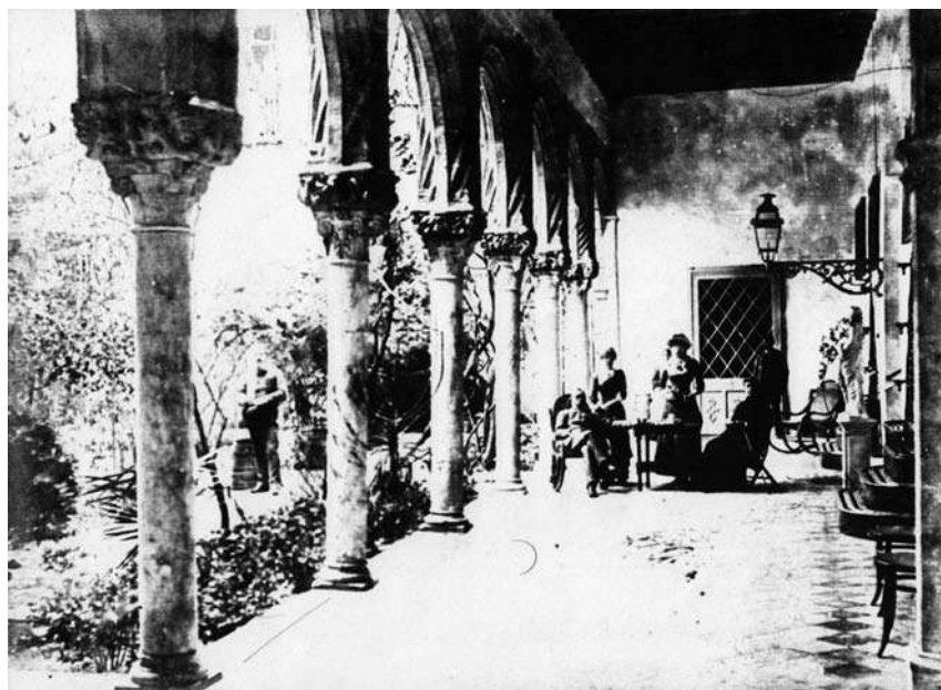
2.- Galería del jardín de una casa de El Puerto de Santa María.
