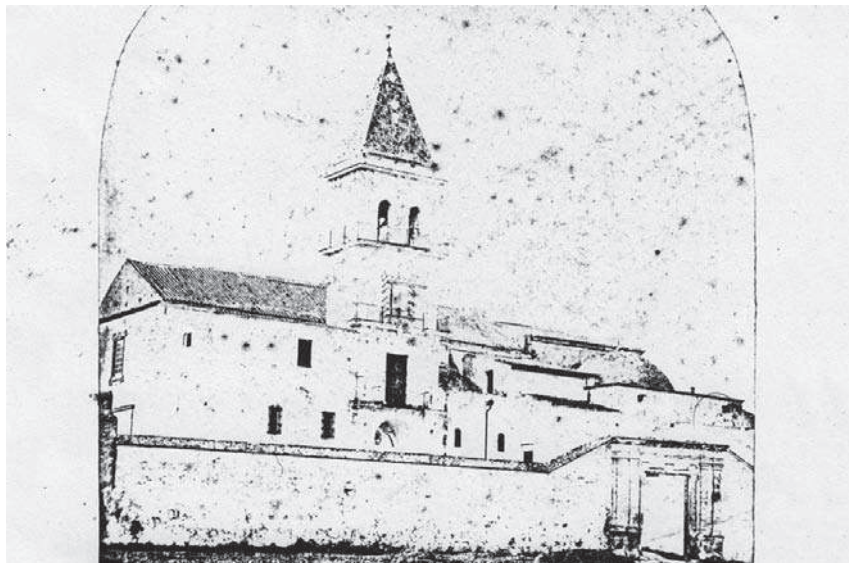
5. Descripción de John V. Drysdale Wilson: “Un edificio con una torre que sobresale con un tejado puntiagudo”. Nota editorial: Convento de San Francisco
