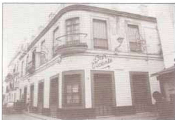
Foto nº8 Estado actual de las carnicerías tras las reformas de 1881.
