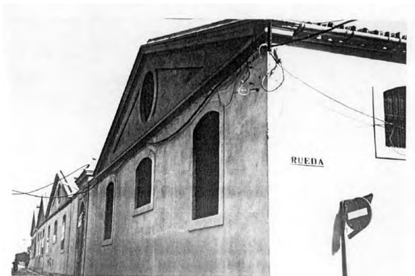
FOTO 1. FACHADA PRINCIPAL DE LA BODEGA RESTAURADA Y CONSERVADA, DESDE LA ESQUINA DE LA C/ ZARZA CON C/ RUEDA.
